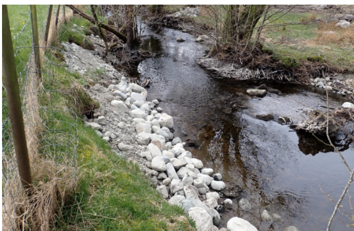
Figur 6: Bildet er hentet fra erosjonssikringstiltak i Årvikelva i Tysvær, og viser riktig utførelse av miljøvennlig erosjonssikringsteknikk ved bruk av morenemasser av stein i forskjellige størrelser.
